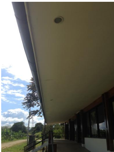
Figura 23. Mantenimiento de Edificio.
