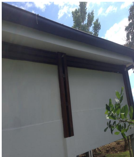
Figura 21. Mantenimiento de Edificio.
