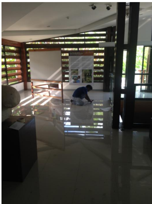
Figura 22. Mantenimiento de Edificio.
