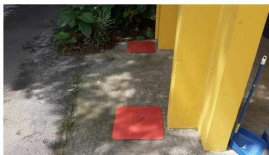
Contruccion de cajas de registro y de contruccion de tapas (Sede de Santo Domingo)
