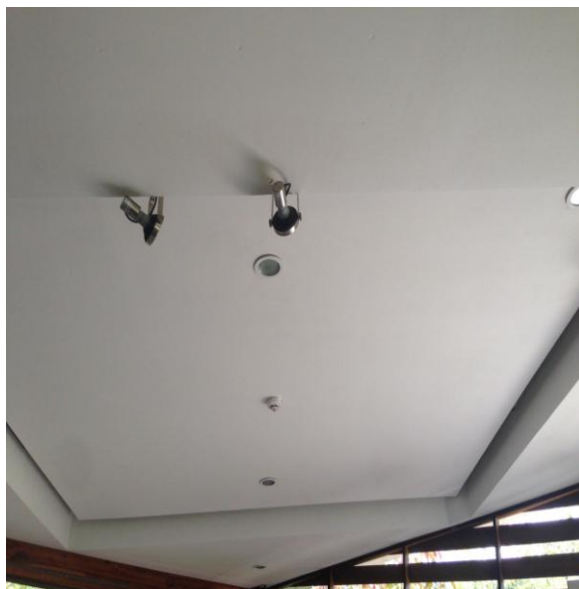
Figura 24. Mantenimiento de Edificio.
