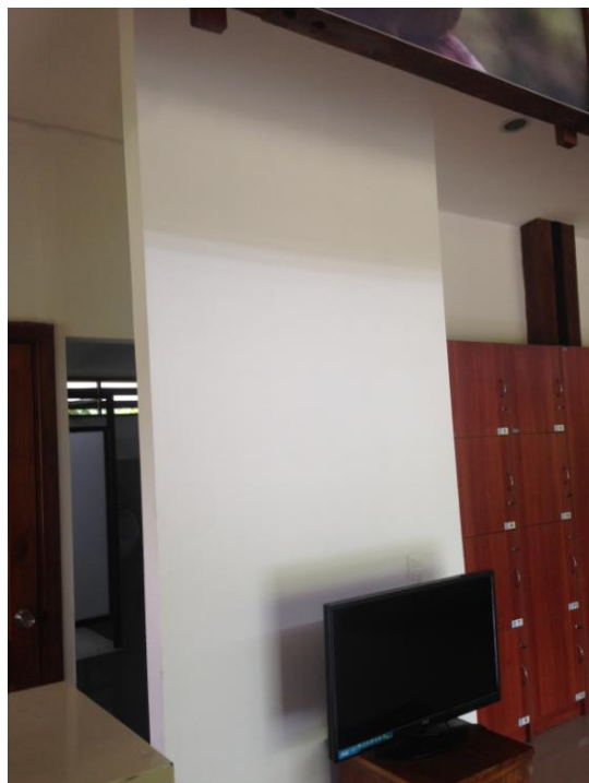
Figura 25. Mantenimiento de Edificio.
