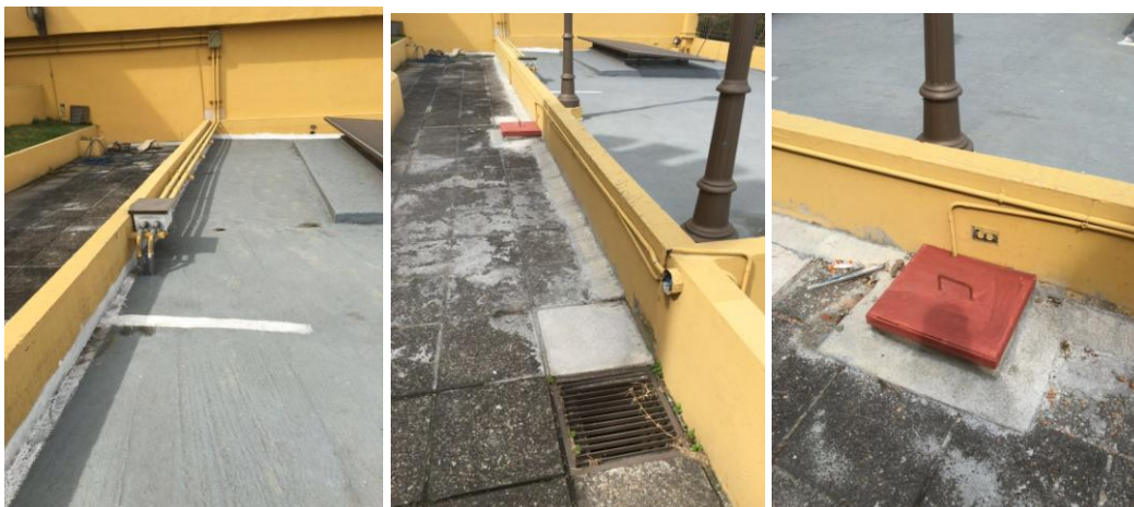
Reparaciones en la losa donde se encuentra el Área de Informática
